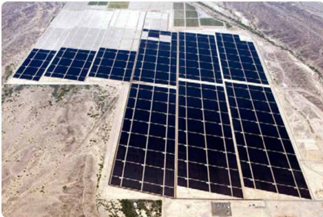
圖1. 亞利桑那州尤馬縣太陽能光電發電設備
