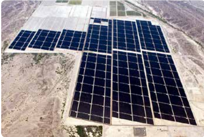
图1. 亚利桑那州尤马县太阳能光伏发电设备 1
